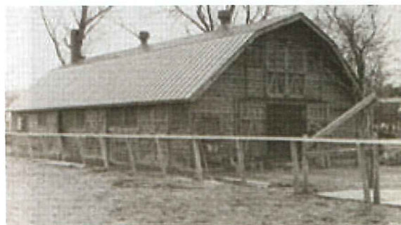
図6 完成した18条厩舎 昭和46年撮影
